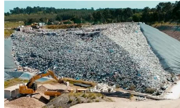
Enfouissement des déchets ultimes
